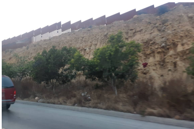
Figura 4. Una vista al muro desde la carretera
