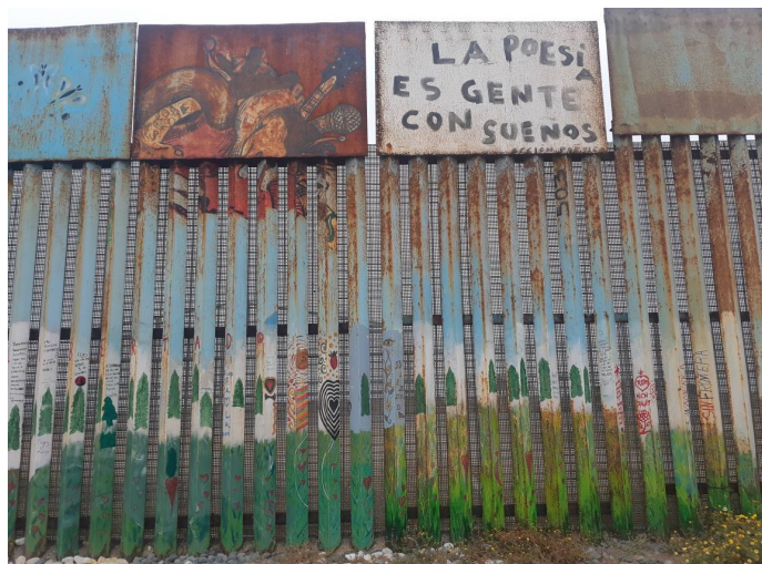
Figura 12. Detalle del muro
