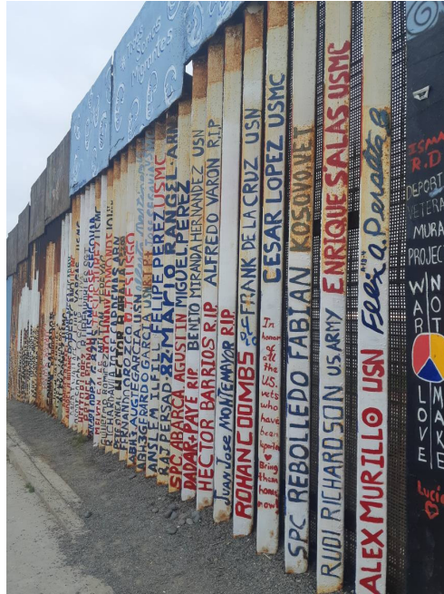
Figura 11. Detalle del muro
